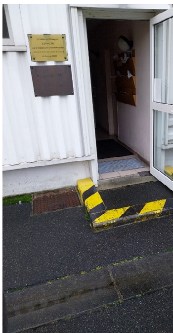
Figure 25 : Photographies de dispositifs de rétention du bâtiment 0105
