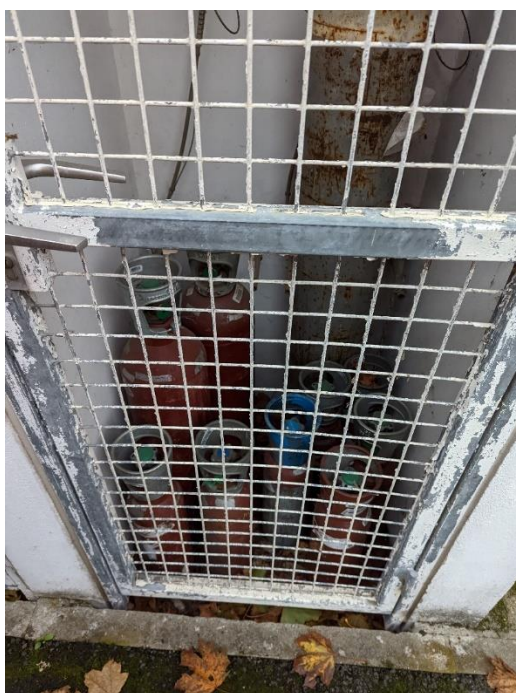
Figure 17 : Stockage de bouteilles d'acétylène
