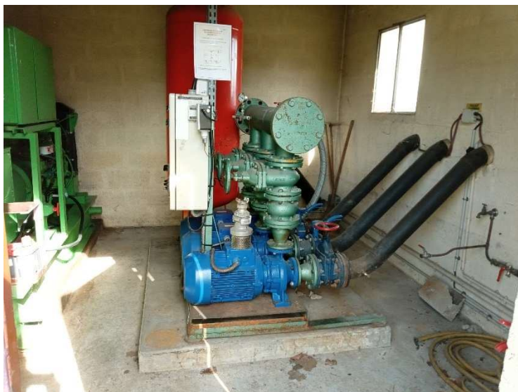
Figure 2 : Surpresseurs alimentant le réseau incendie
