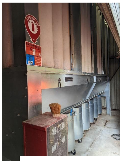
Figure 11 : filtres du système d'aspiration des poussières de bois
